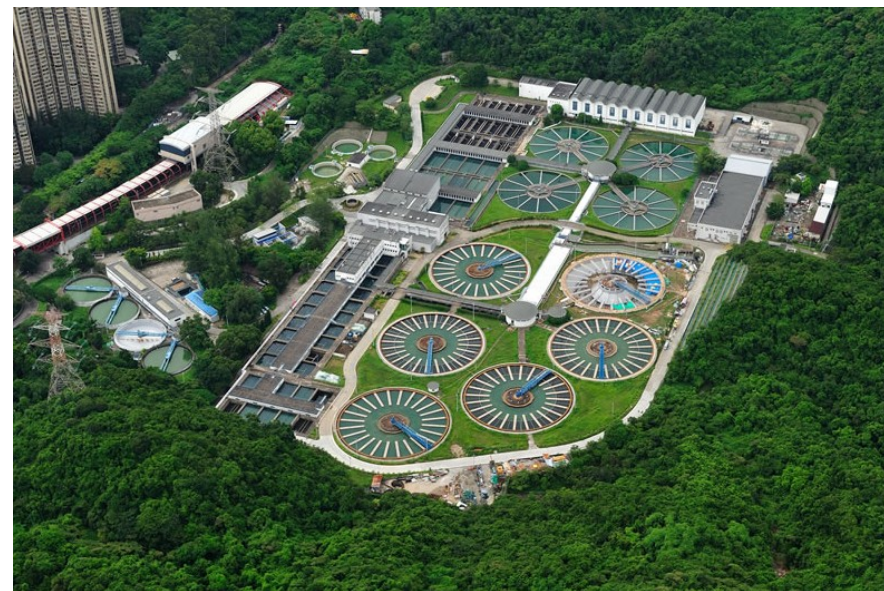
圖 9 沙田濾水廠的氯氣儲存設施
