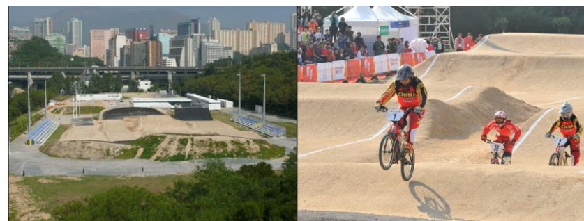
圖 39 修復後醉酒灣堆填區的「香港賽馬會國際小輪車場」
